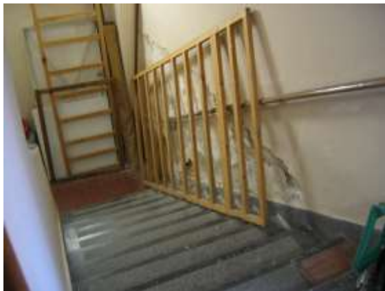
Beázások nyomai a lépcsőházban és a történeti raktárban
