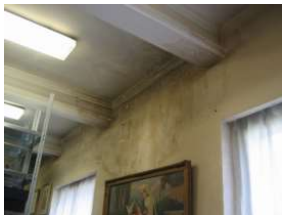
Beázások nyomai a lépcsőházban és a történeti raktárban
